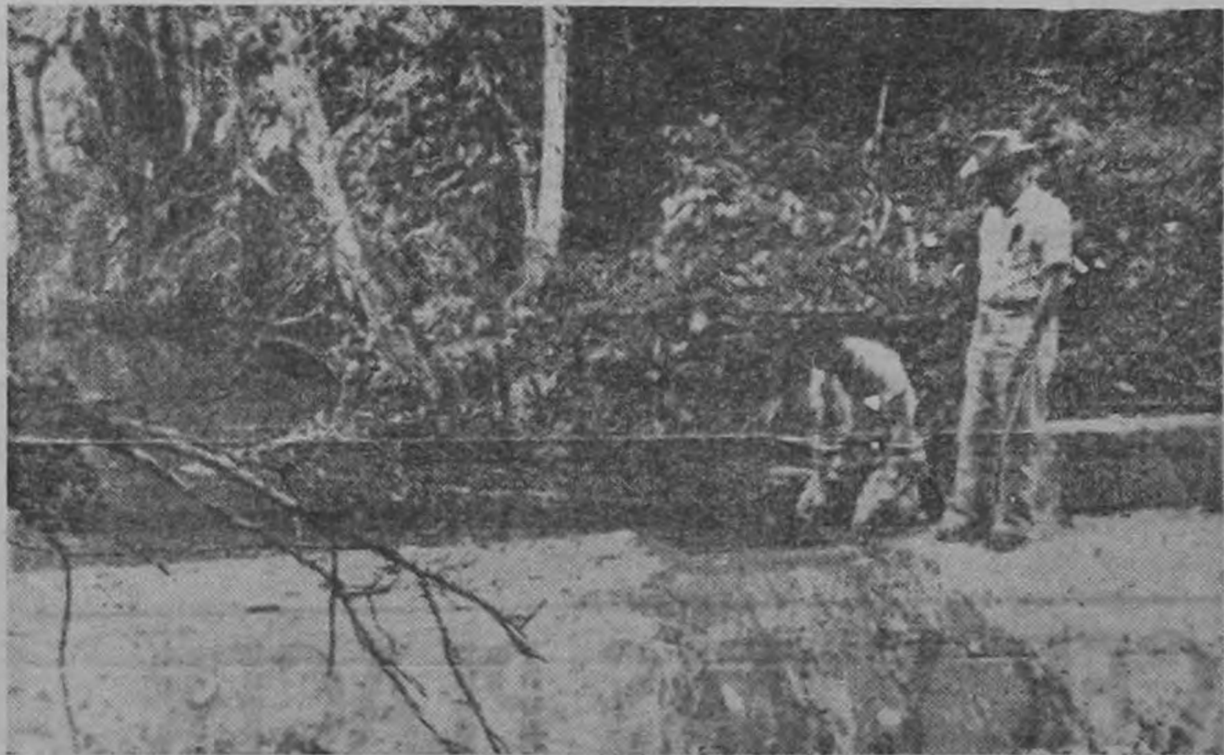
Presa de nueve metros para toma de aguas de la Quebrada Guadalupe, en Coronado.
