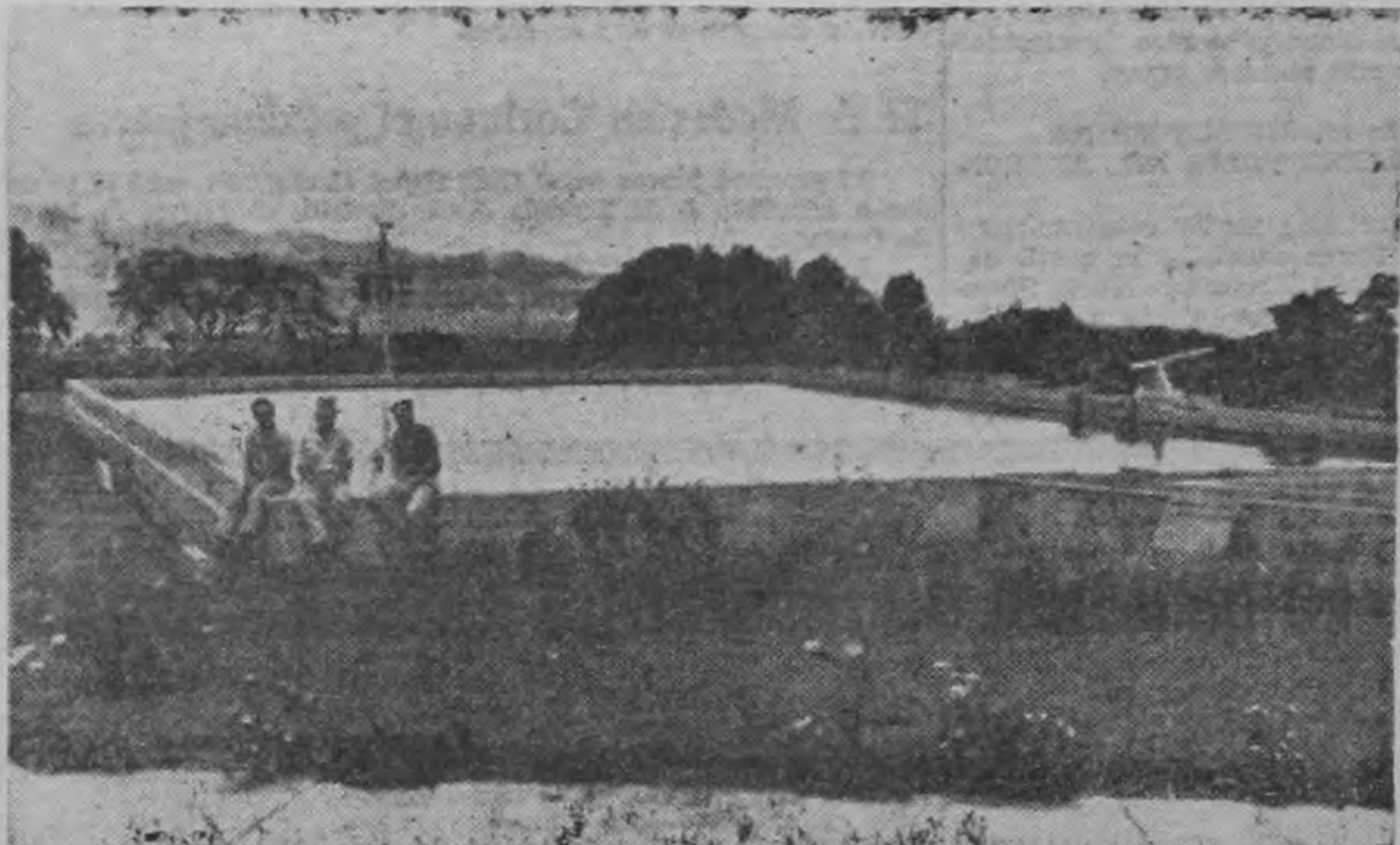
Tanque viejo de distribución acondicionado como tanque presedimentador.
