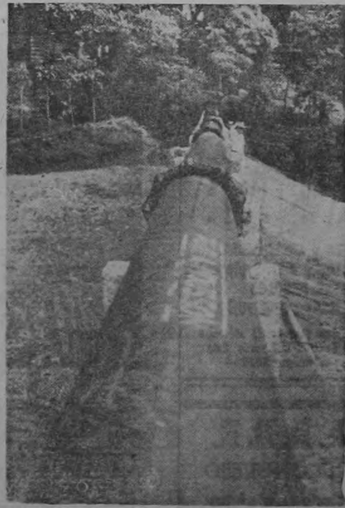
Filtración de aguas de la Quebrada Honda, a través del Río Viras.
